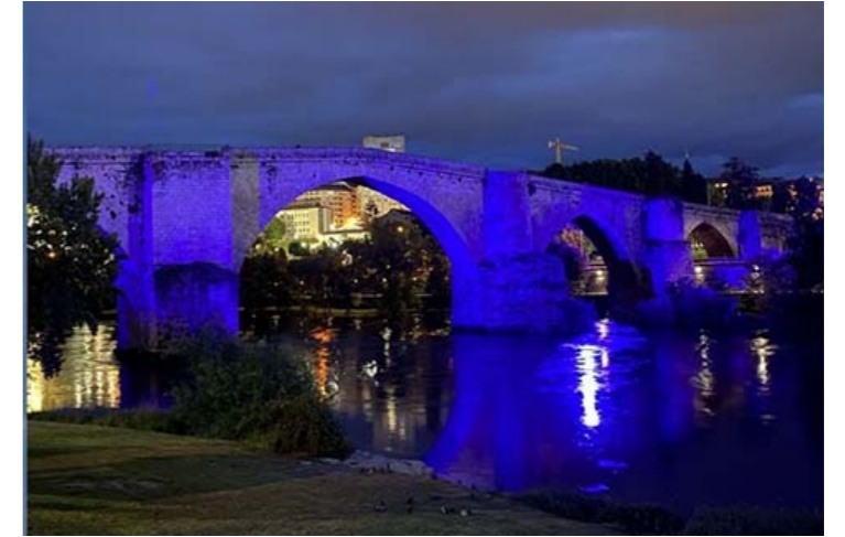
Puente medieval (Orense)
